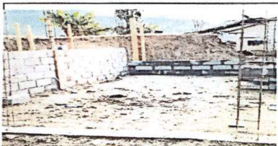
Inicio de la construcción de la pared.
