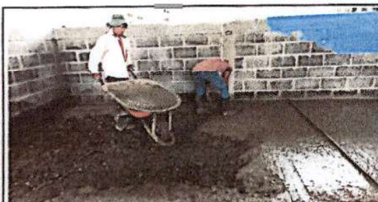
Instalación de piso líquido interior.
