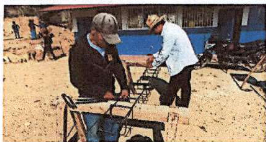
Inicio Preparación de armadura para columnas.
