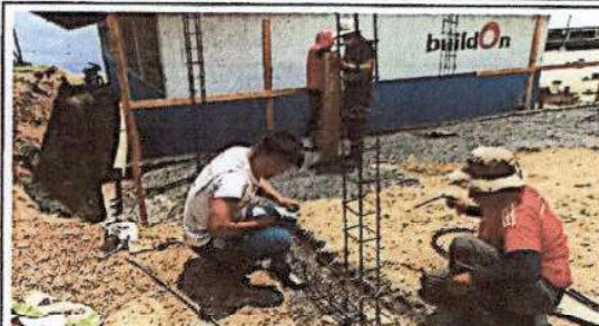
Armadura de la solera de inicio.
