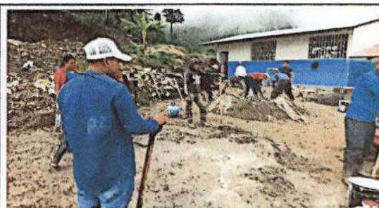
Preparación de la mezcla para piso líquido.
