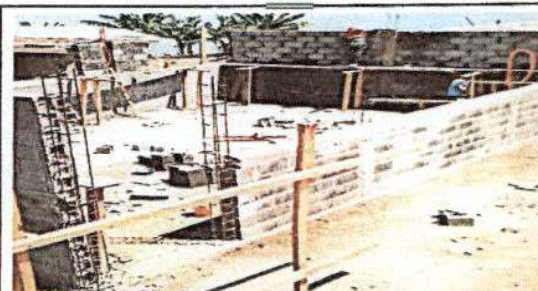
Construcción de la pared y soleras de por medio.
